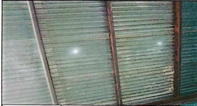
Foto1: SE REALIZARÁ CAMBIO DE ESTRUCTURA DE TECHO (CAMBIO DE LAMINAS Y COSTANERAS)
